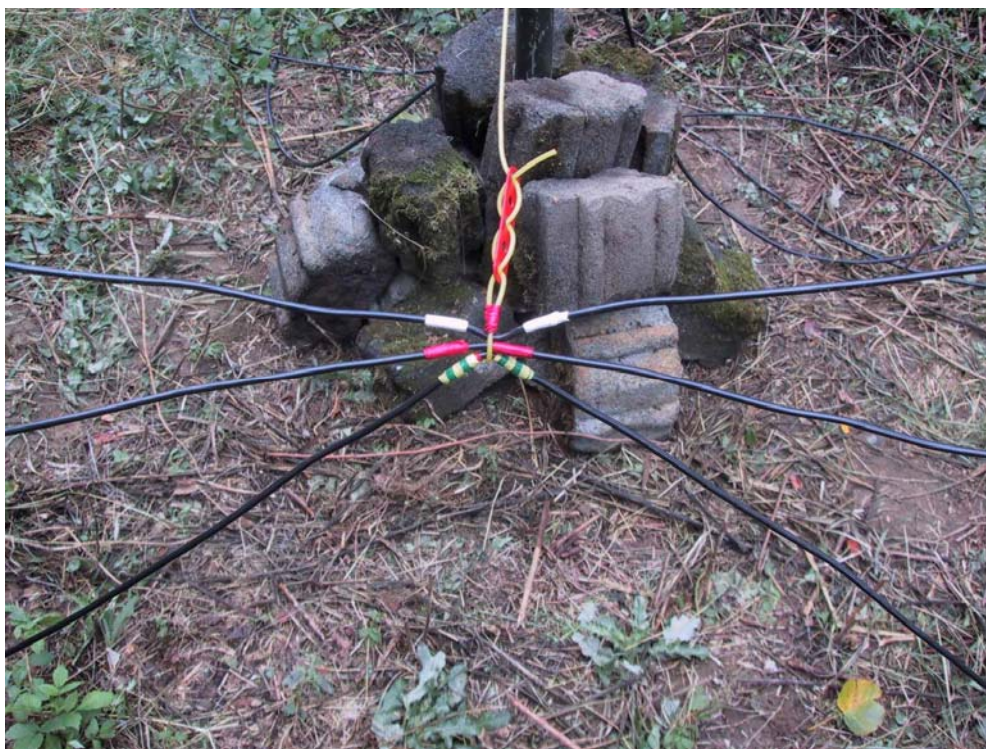
Obr. 11. Přitažení prvků reflektorů k základové desce.
